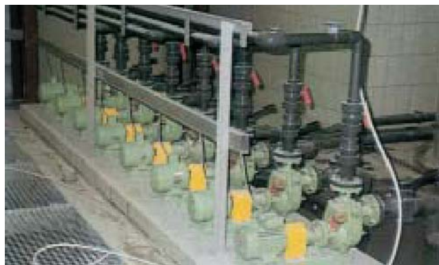
Серия насосов из нержавеющей стали J40. Работа на очистной станции.
