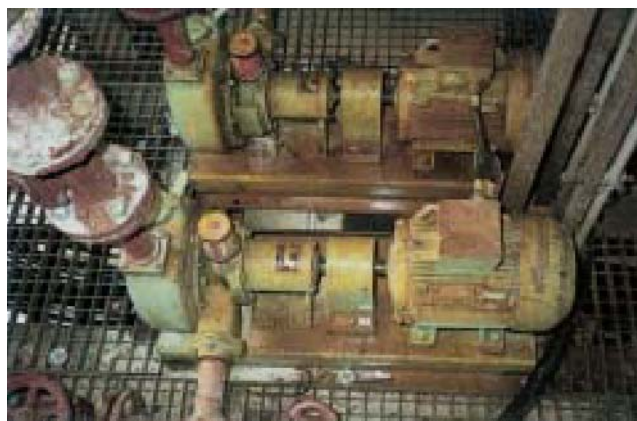
Насосы J30-180. дозировка нейтрализующей жидкости.
